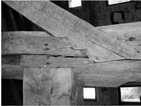
Detalle del ensamblaje de las vigas de madera en el Caserío Zabalaga del museo Chillida Leku
